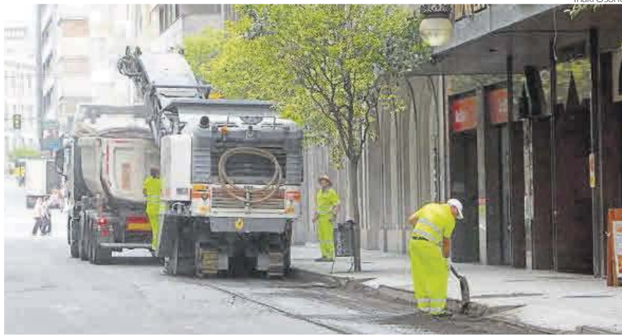
Inicio de las obras de renovación en Progreso para mejorar la seguridad vial y peatonal.
