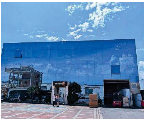
Instalaciones de Amiab en el Polígono Industrial Romica. / AMIAB
