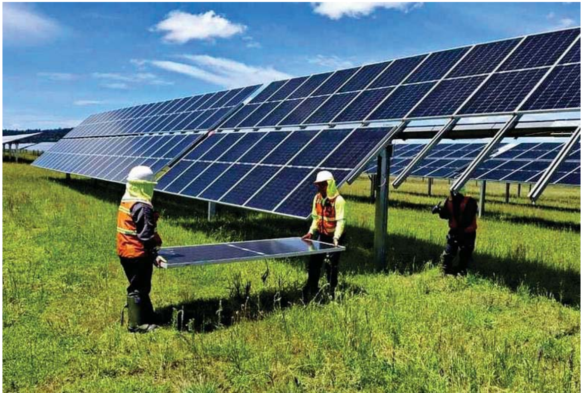
Instalación de placas eólicas por parte de técnicos especializados. / SOLARIG
