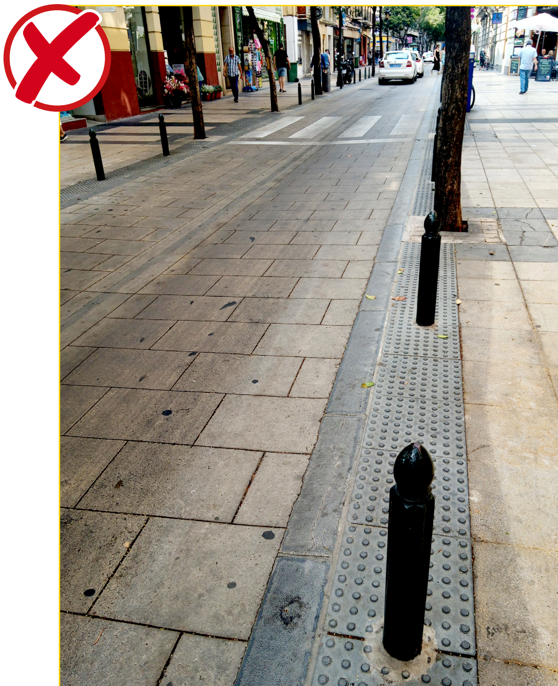
Imatge 35. No hi ha diferència entre paviment de calçada i vorera.
