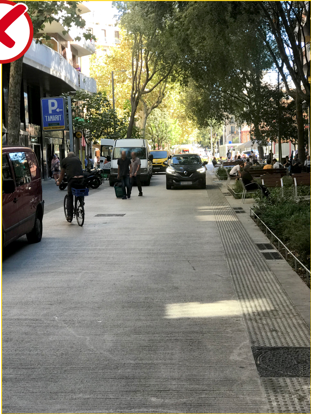
Imatge 29. Col·locació incorrecta de franja de senyalització d'advertència.
