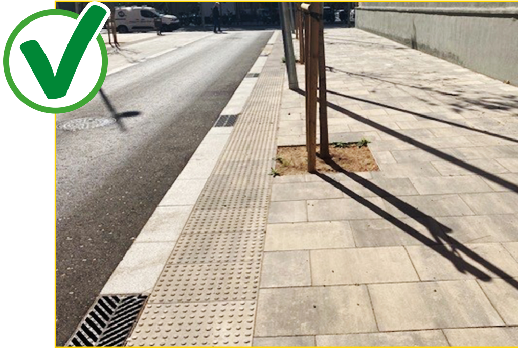
Imatge 33. Delimitació adequada de vorera i calçada.
