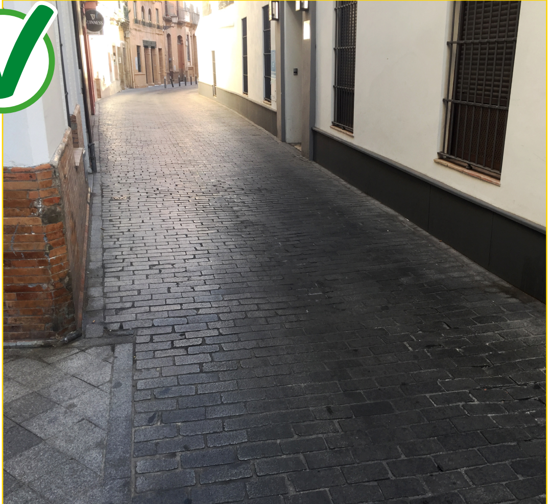
Imatge 21. Carrer on no és possible delimitar una zona de major seguretat.
