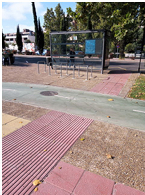
Figura 3. Pavimento direccional interrumpido por carril bici
