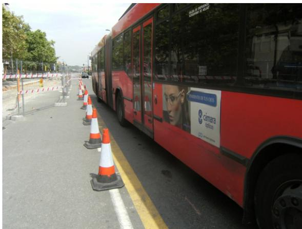
Figura 9. Obstáculo junto a parada de autobús. Pasarela con una altura muy baja que resulta peligrosa
