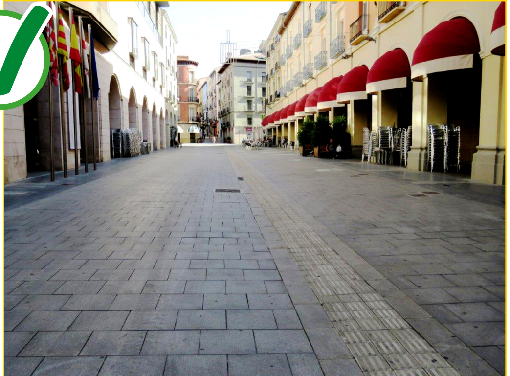
Imaxe 14. Presenza de pavimento de acanaladura por imposibilidade de sinalizar a zona segura próxima á fachada.
