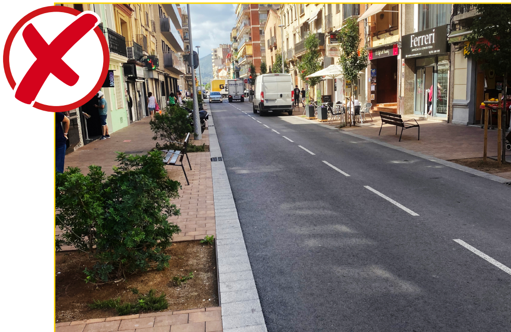
Imaxe 34. Ausencia de delimitación mediante pavimento de advertencia.
