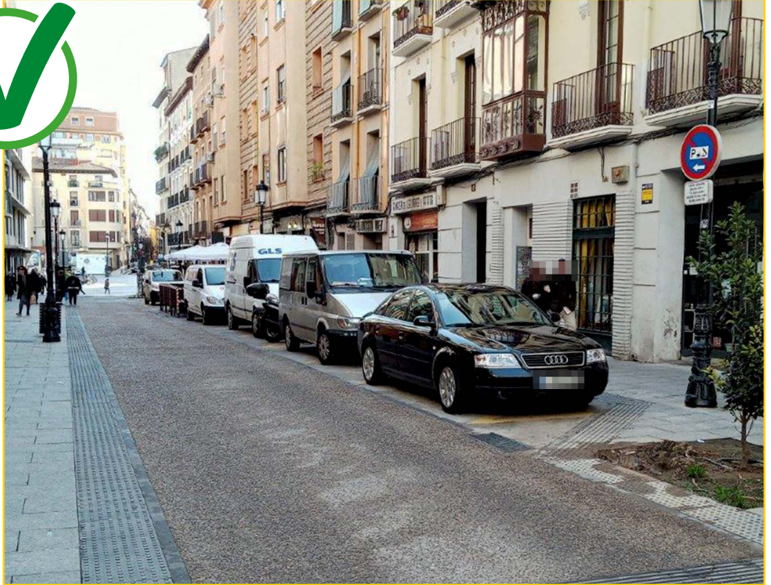
Imaxe 41. Sinalización que informa axeitadamente da zona e das condicións do estacionamento. Sen embargo, o pavimento tacto-visual non se acompaña de suficiente mobiliario delimitador.
