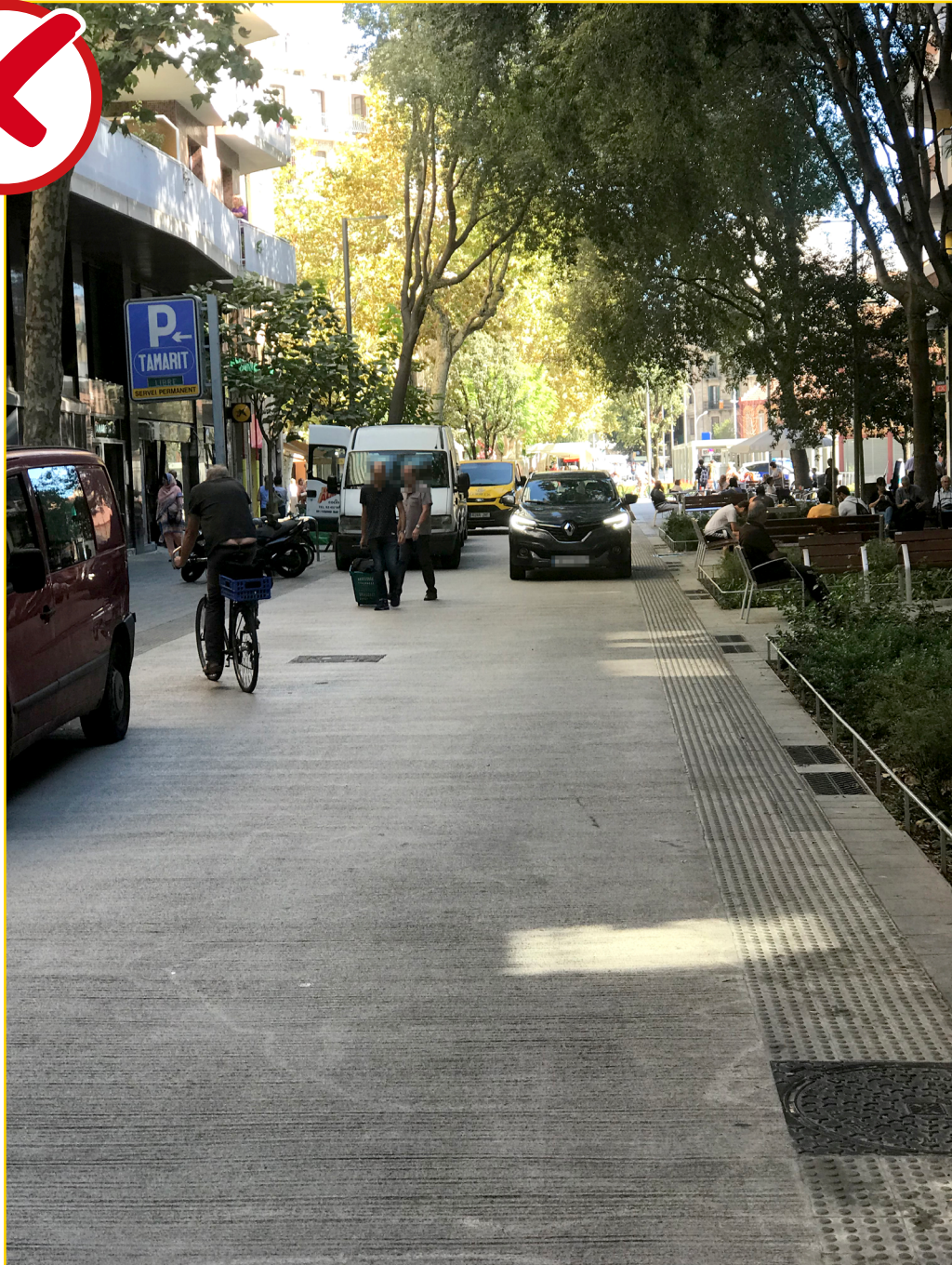
Imaxe 29. Incorrecta colocación da franxa de sinalización de advertencia.
