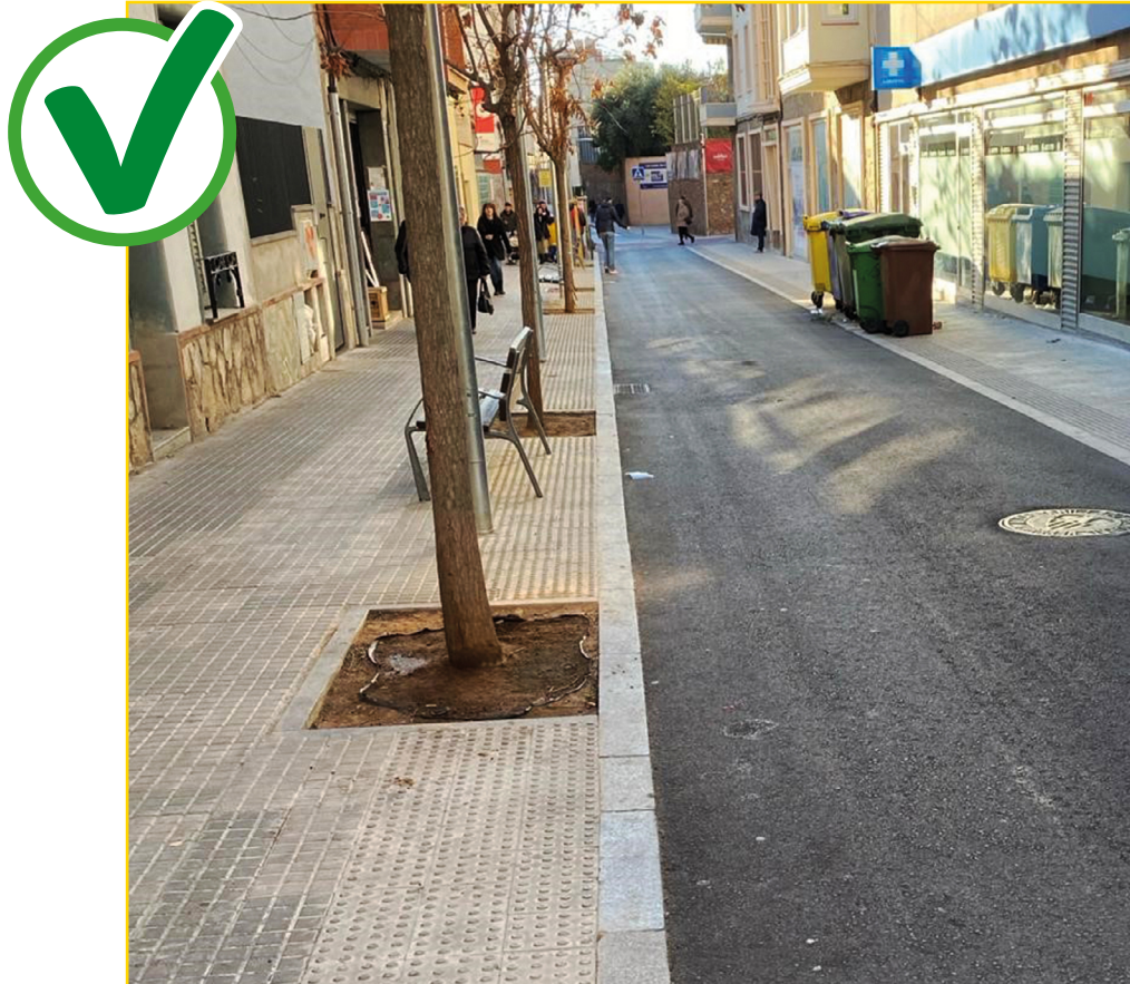
Imaxe 31. Deseño axeitado, no que se diferencian inequivocamente cada unha das zonas.
