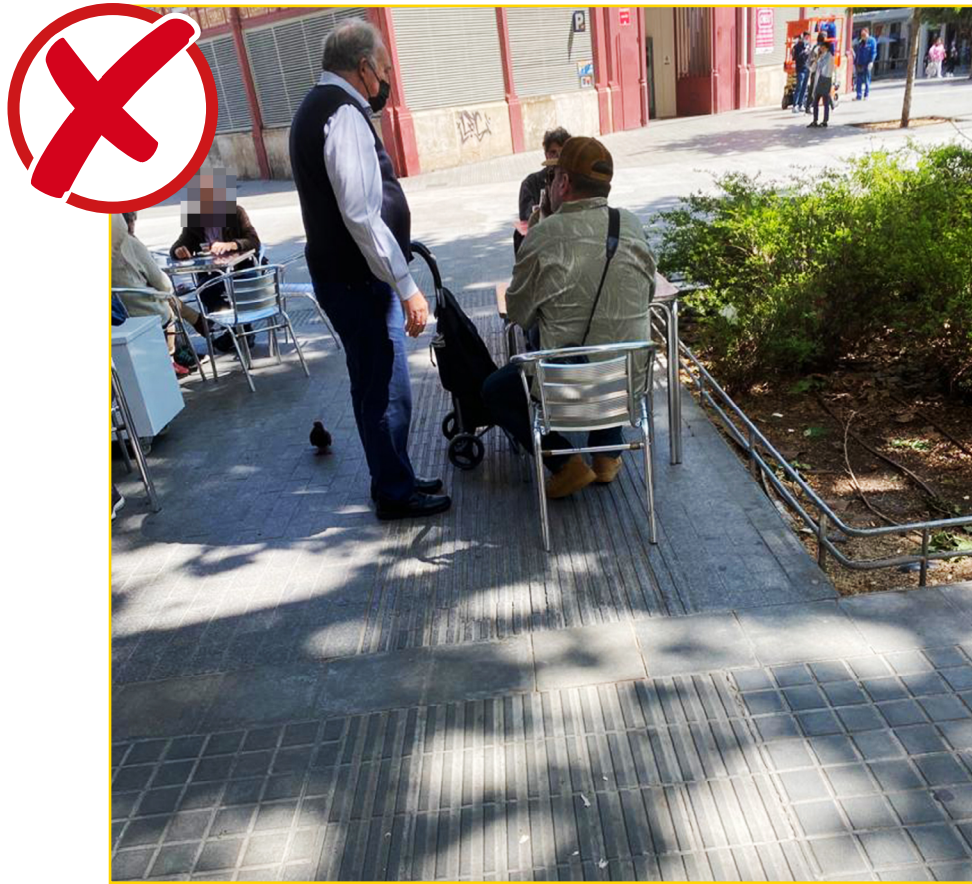
Imaxe 18. Veladores sobre o pavimento tacto-visual.
