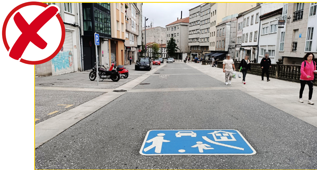
Imaxe 39. Sinalización non axeitada en plataforma de tránsito diferenciados, que suxire un uso compartido dese espazo.
