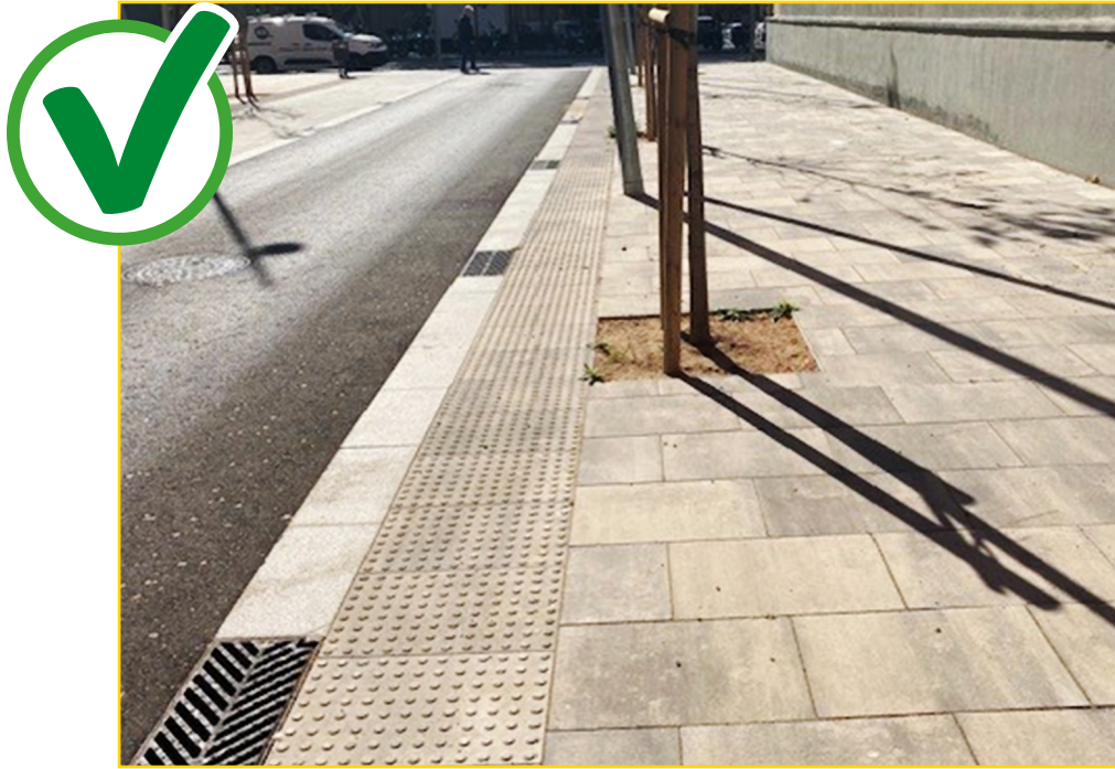
Imaxe 33. Delimitación axeitada de beirarrúa e calzada.
