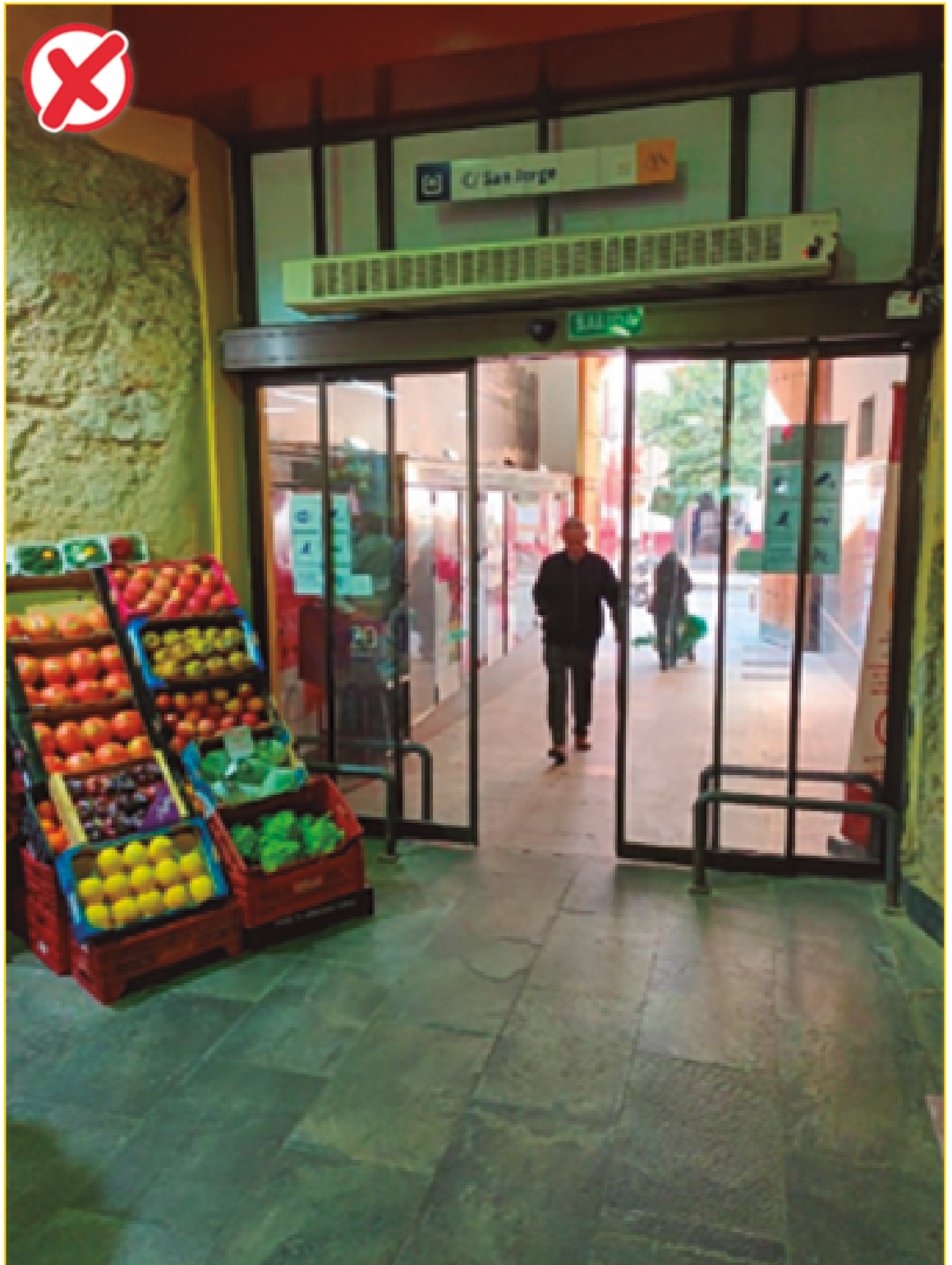
Imagen 25. Cartel ubicado a excesiva altura, de difícil localización y con tamaño de letra deficiente. Falta de iluminación.
