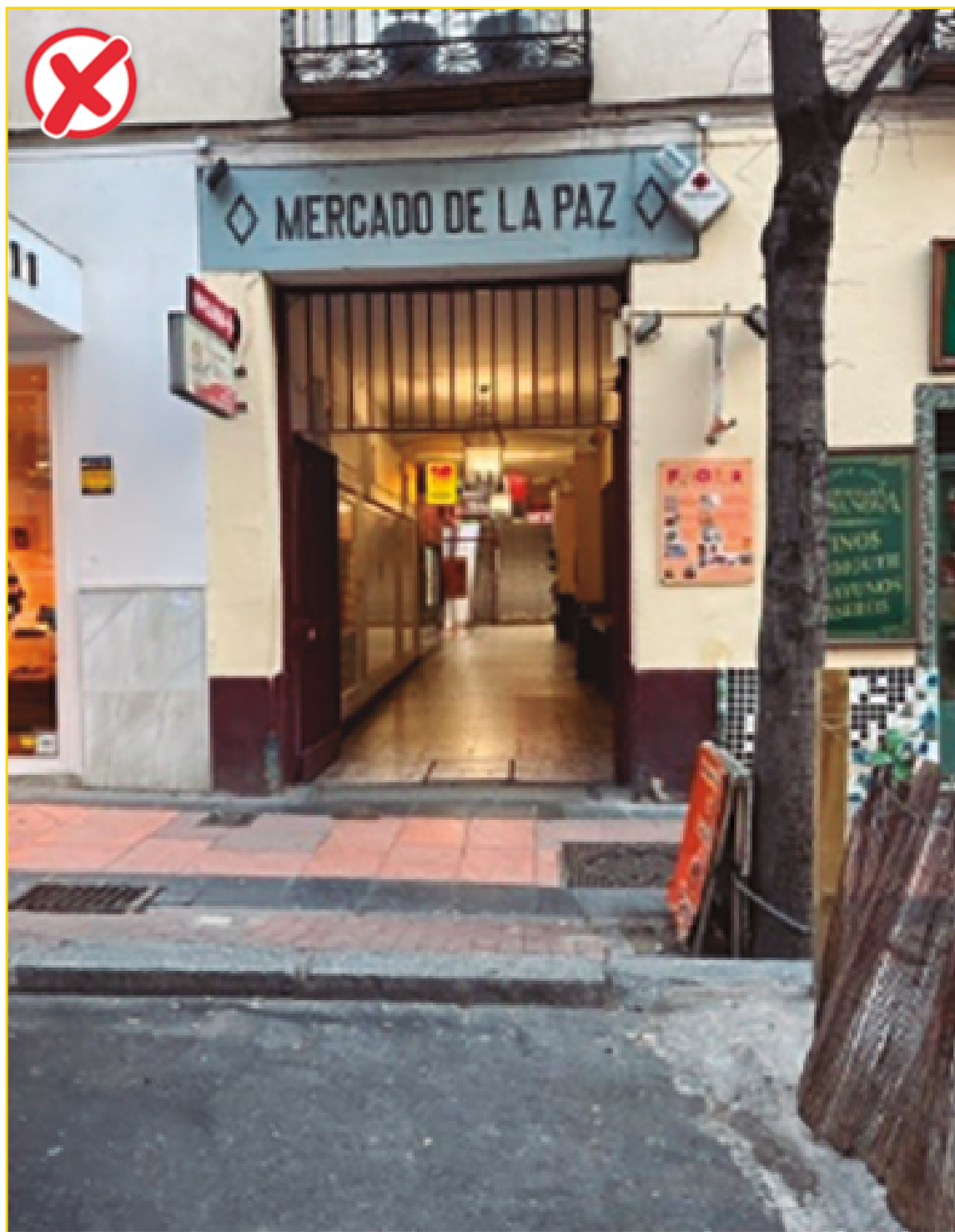
Imagen 2. Entrada principal difícilmente detectable, que no ofrece referencias espaciales ni visuales suficientes y no facilita una aproximación segura y autónoma.
