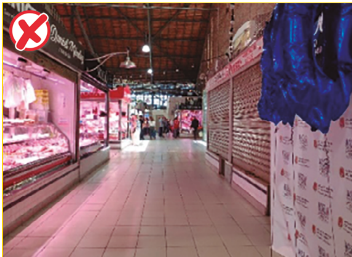
Imagen 14. Escasa iluminación general con diferencias bruscas de luz entre espacios y presencia de reflejos en las superficies.
