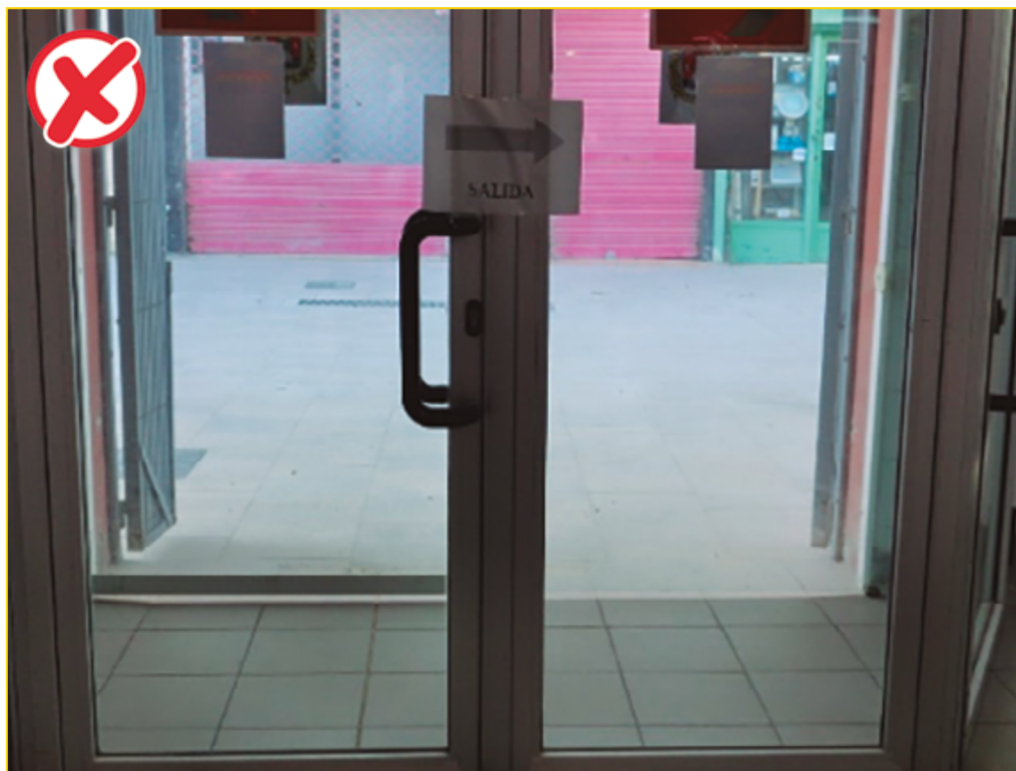
Imagen 24. Cartelería orientadora en soporte inestable, localización "inesperada", mal contraste, insuficiente información y falta de iluminación.
