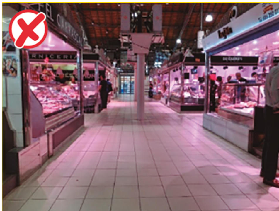
Imagen 4. Presencia de columnas en la línea de paso con bajo contraste y sin señalizar. Iluminación mal focalizada.
